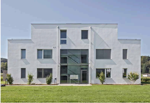
5722 Gränichen, Moortalstrasse 6C
